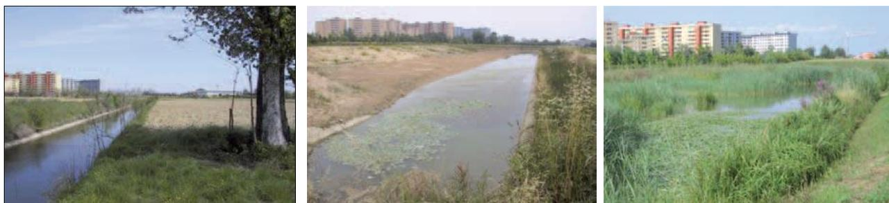
L'ampliamento del corso d'acqua può attuarsi anche con allargamento della sezione tramite risagomatura con pendenza delle scarpate inferiori rispetto a quelle attuali peraltro non uniformi.
