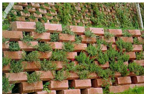
Barriera antirumore in calcestruzzo ed elementi vegetali
